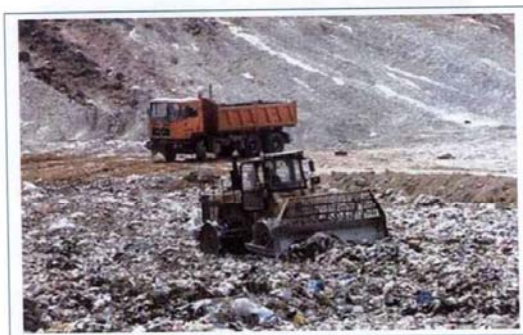
Слика бр. 3 - Планирање и набивање на отпадот
