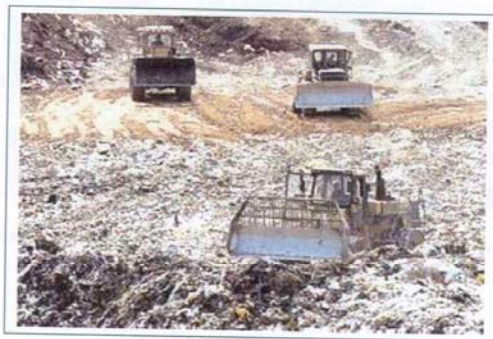
Слика бр 12 - Компактирање на отпадот и негово покривање со земја
