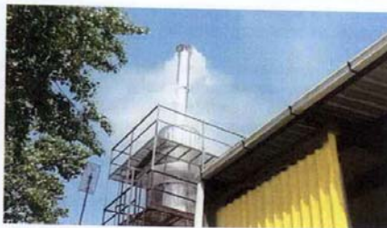
Слика бр 10 - Надградба на оџакот на инцинераторот
